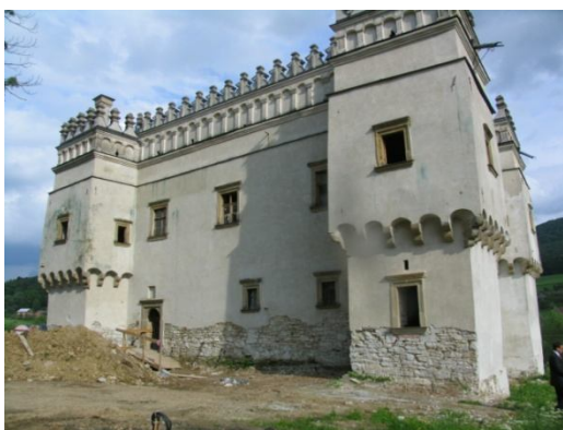
Fot.1 Otoczenie obiektu wykazuje spadek w kierunku rzeki
